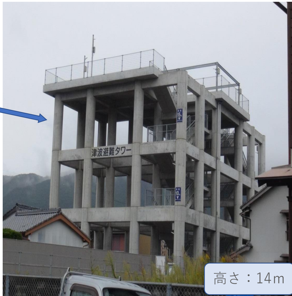
写真2：2015年建設の津波避難タワー
