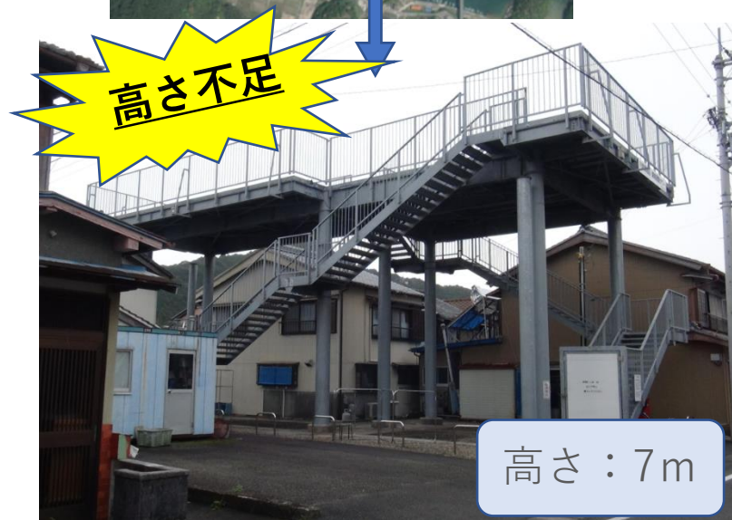
写真1：2009年建設の津波避難タワー
